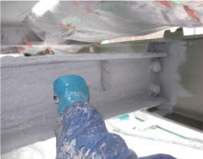
スプレー後ローラーで表面均し
